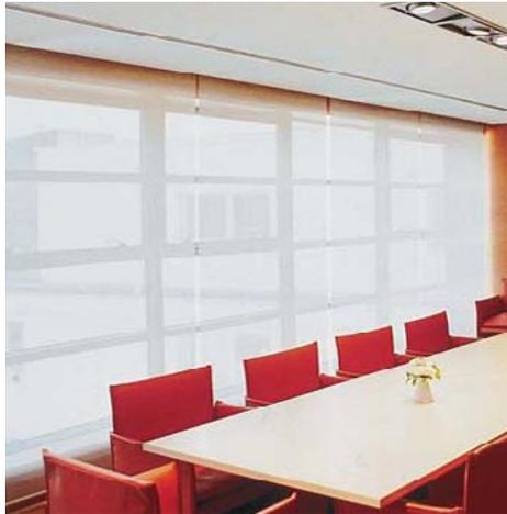
Die Steuerstrategie Sonnenschutz reguliert die Behänge unter klimatischen Aspekten. Je nach Jahreszeit werden wärmende Sonnenstrahlen entweder ausgesperrt oder herein gelassen. Eine eventuell vorhandene Klimatisierung kann energiesparend zurückgefahren werden.
