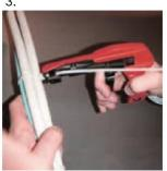
Anziehen des Kabelbinder bis die Anzugskraft erreicht
